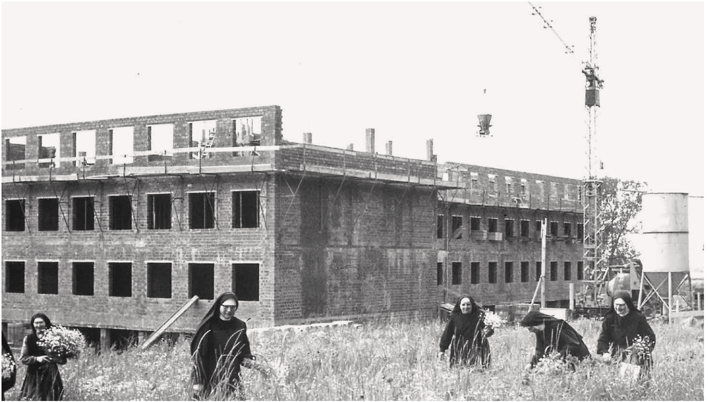
Bild oben Regelmäßig kommen die Schwestern nach Laupheim, um den Baufortschritt zu begutachten.
